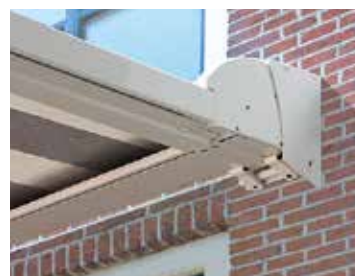
Novatop Pergola XL an der Fassade montiert
