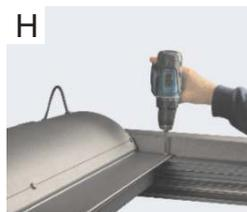
Montieren Sie abschließend die Dacherweiterung an das Kastendach der Horizontalmarkise (Abb. G+H).
