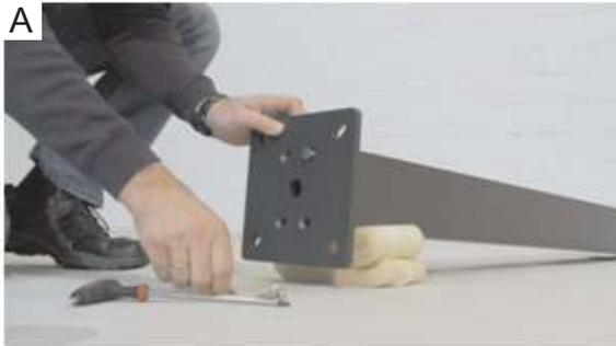
Befestigen Sie an allen Stützpfosten die mitgelieferten Bodenplatten mit je 4 Senkschrauben M8x25. Schrauben entnehmen Sie aus der Schraubenbox (Abb. A).
