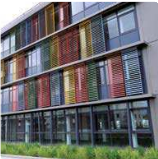
Patio®, Colombe Parc Offices, Toulouse-Colomiers (FR)
